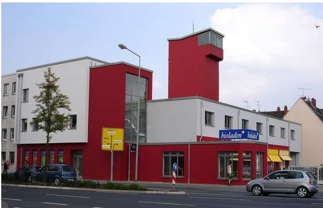
Abbildung 24: Alte Feuerwache nach dem Umbau
