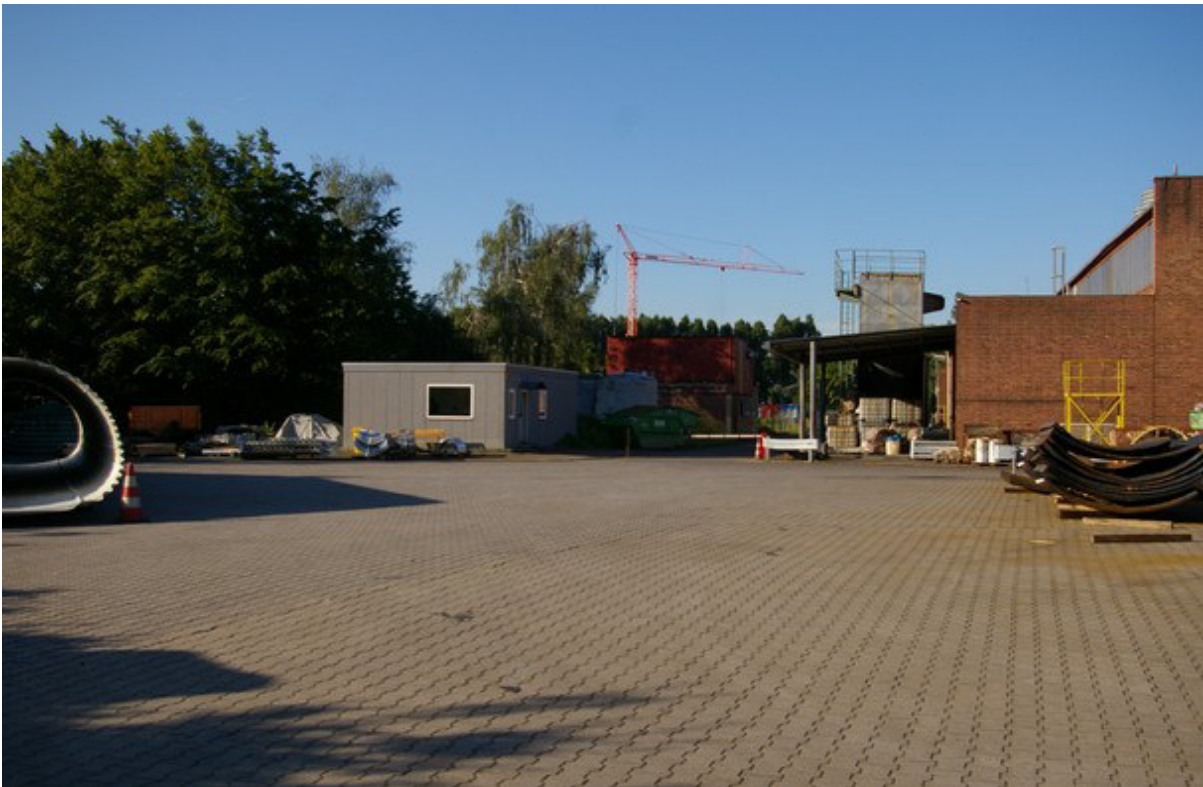
Abbildung 10: Betriebsgelände der Firma Hamco, Blick auf das östliche Siedlungsgehölz und den Beginn des Geltungsbereichs
